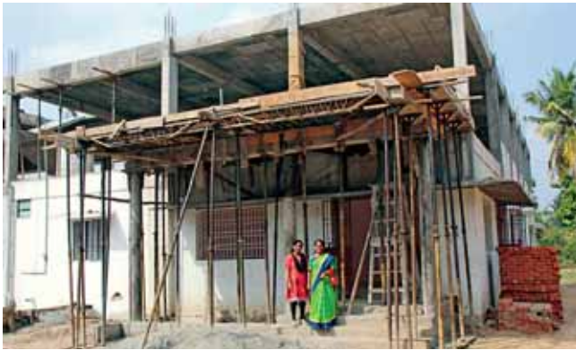
Schon viel geschafft und noch viel Arbeit zu tun – das Mädchenheim in Porayar nimmt von Tag zu Tag Gestalt an.
